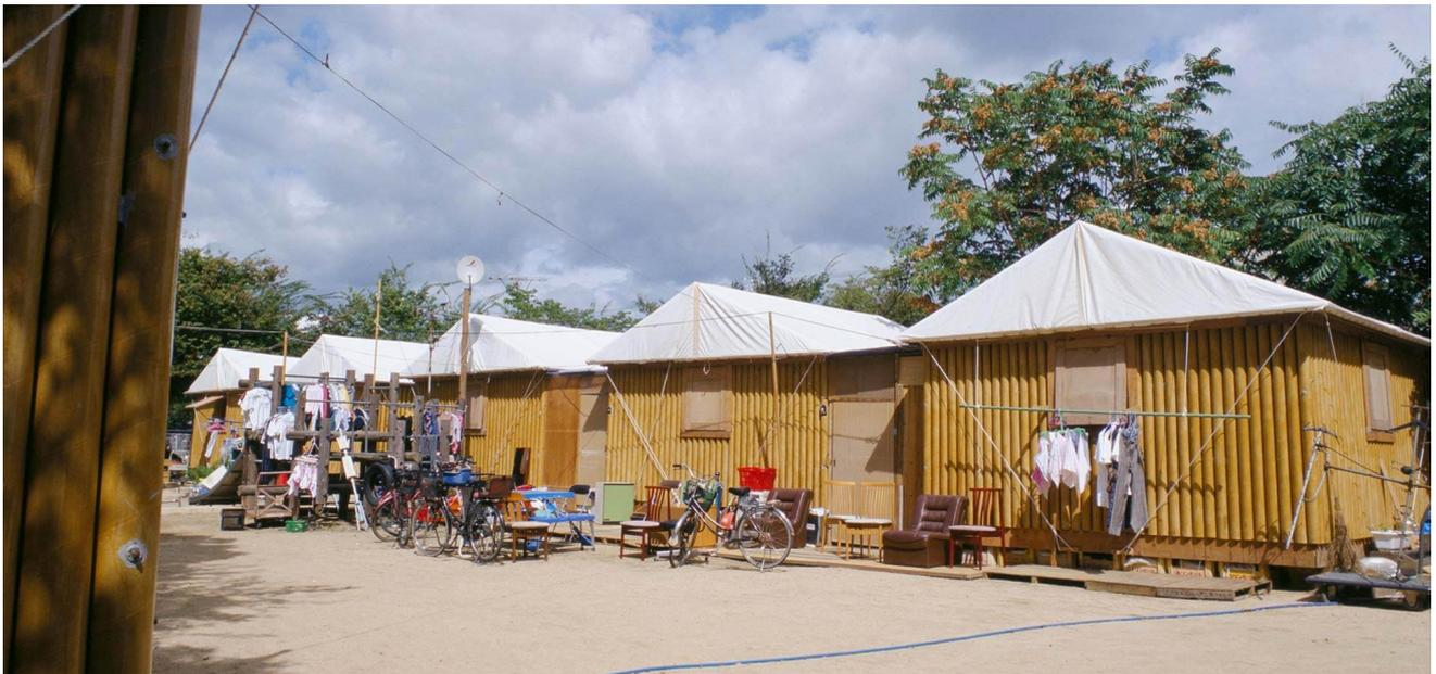
阪神大震災の被災者のためにつくられた仮設の紙のログハウス。安価で誰でも簡単に組み立てられ、夏冬の断熱性能を有するよう設計が進められた。基礎には砂袋入りのピールケース、壁と小屋組は紙管、天井と屋根にテント膜を使用している。コストを抑えるとともに、解体しやすさ、残材の処分、サイクルコストの面でも優れたものとなっている。
