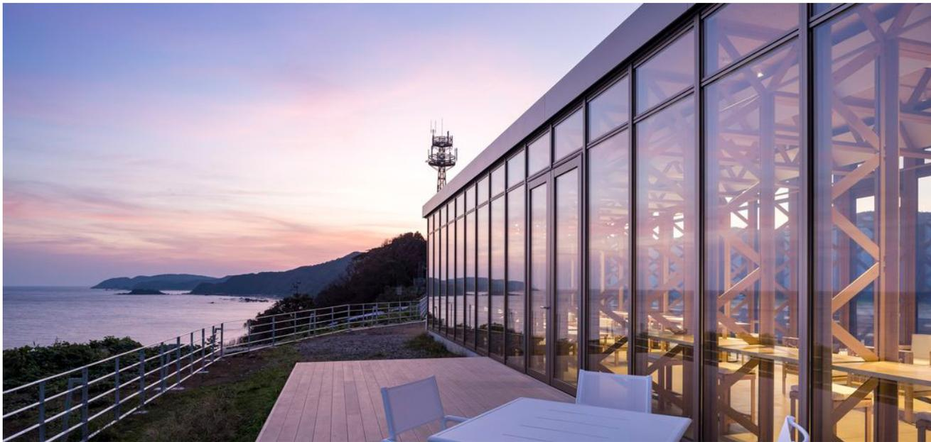
日本海への素晴らしい眺望を生かし、建物は横 とし、海に対して並行に配置した。屋内のどこからでも海を感じられるよう、全体をガラス張りとしている。構造体は無垢のヒノキの板材を特殊な技術でL型形状に圧縮してトラスを構成することにより、鉄骨造のような繊細な架構を木造で実現した。家具は合板をL型に曲げた成形合板を用いて、イスやテーブルを構成している。
