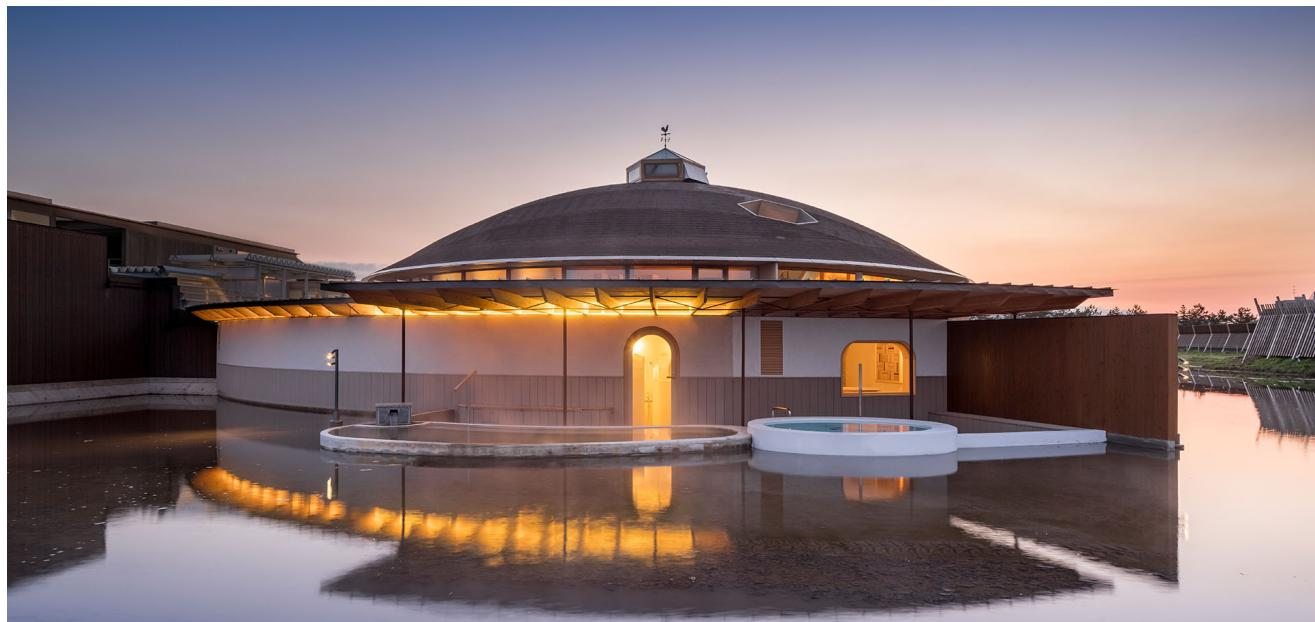
大浴場の屋根は、ポンピドーセンター・メスの屋根と同じ、各ジョイントに2方向の材しか交わらないよう六角形と三角形のジオメトリーを、上 下弦が木片で構成されたフィーレンディールトラス状の竹を編んだ帽子のような構造のドームとした。女性サウナには細い丸太を天井まで並べた木製ベンチを設けた。正面の大きな窓からは一面に広がるスイデンを望むことができる。壁には山形県産の果樹で制作した「果樹パネル」が掛けられ、自動給水によって木にかかる水分が蒸発し、果樹の香りが室内に広がると共に室内の湿度を一定に保つ役割を担っている。水風呂は既存露天風呂に隣接して配置し、スイデンに浸かっているような開放感を与える。男性サウナは既存男湯露天風呂の六角形の天窓に合わせて水風呂を六角形とし、サウナ室内のベンチも正六角形柱を組合せたハニカム構造で構成している。庄内の山並みを眺望できるよう横長の窓を配置し、一番低いベンチは可動式のスツールとして自由に座る場所を移動させ、利用者が各々の風景を楽しめるようにした。天井は、既存屋根の木梁架構の形状を活かし、木梁の形成する六角形の彫込み天井とした。
