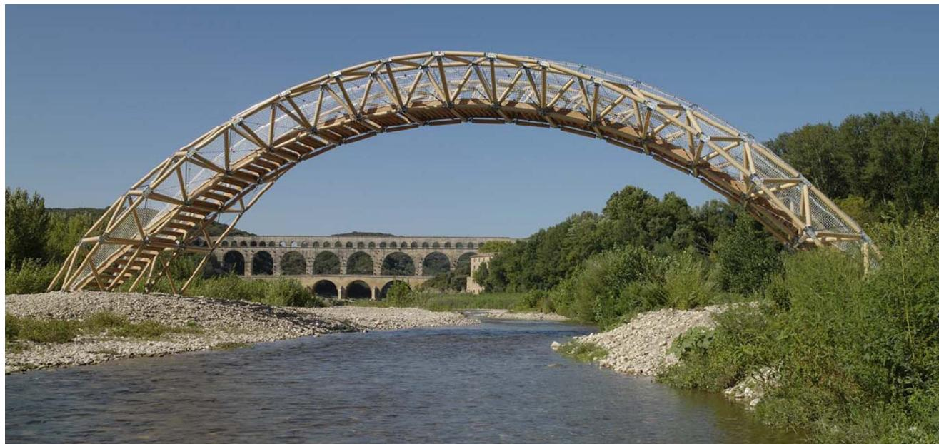
ユネスコの世界遺産に登録されている南仏のニーム近郊にあるローマ時代の水道橋ポン・デュ・ガールの横に紙管でできた歩道橋を建設した。敷地の状況と、構造的合理性から太鼓橋の形状が選択された。ポン・デュ・ガールの「石」という重く、硬く、そして永久性のある素材と、「紙」という軽く、弱く、そして一見短命に思われる素材の材質的なコントラストを見せつつ、紙の橋のアーチの形状をポン・デュ・ガールのアーチと同寸法の円弧とすることで、両方の調和が図られている。構造的には、直径115mm、厚さ19mmの紙管と紙管を繋ぐスチール・ジョイントに、ケーブルでポストテンションを入れてアーチをつくっている。
