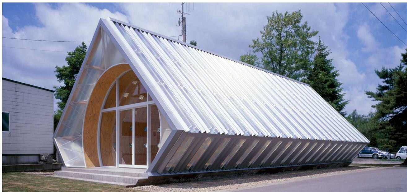
「宇野千代記念館」で取り組んだLVLの網代構造をこの託児所においては圧縮材としてトンネルアーチを形成し、縦横のLVL材格子の穴から室内に適度な自然光が入る空間を考えた。しかし圧縮で使うことで厚みが増すため、結果的に網代構造というよりは、敷地である大館名物「曲げわっぱ構造」となった。大館は多雪地帯であるので、落雪する45°の勾配屋根をLVLのトンネルアーチ上に載せている。ダブルスキンの省エネルギー空間としている。
