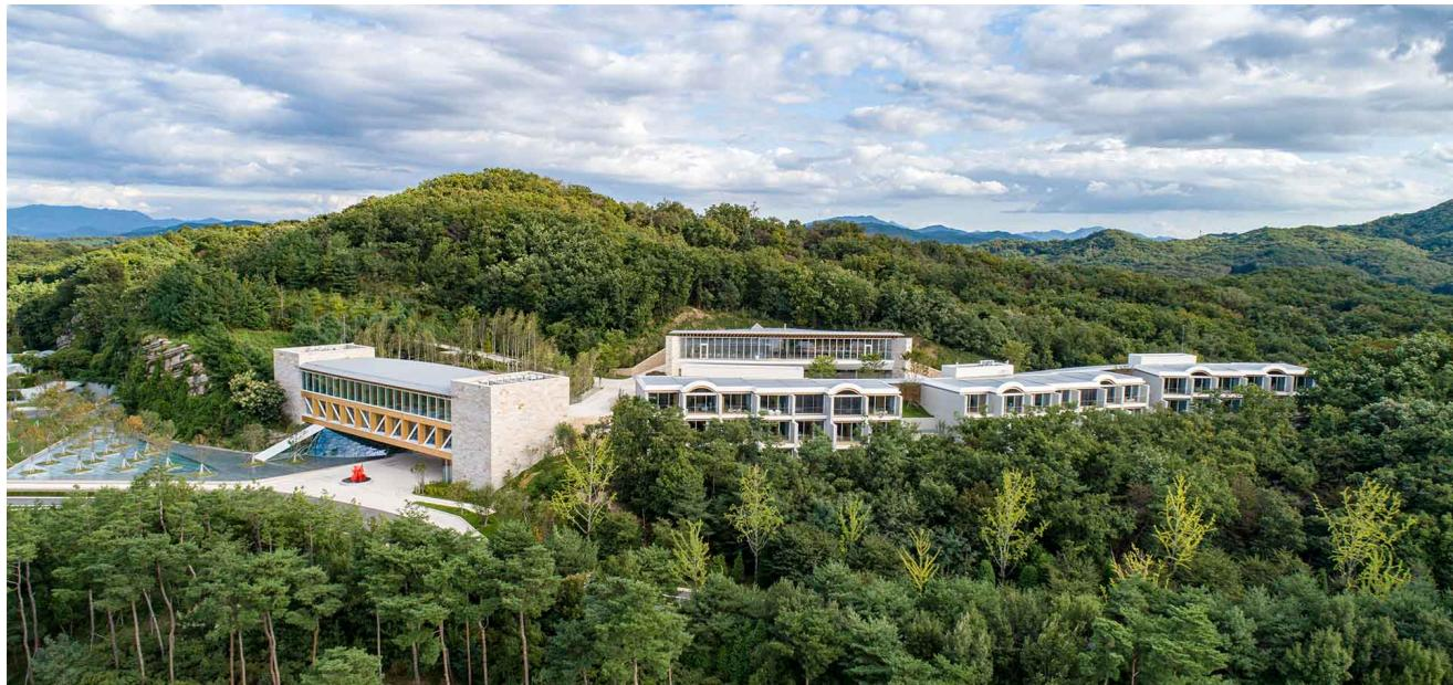
ハムレットは、2009年竣工のヘスリー・ナインブリッジズ・ゴルフクラブの隣に建つ宿泊 研修センターを兼ねた4つの建築群のプロジェクトである。クラブハウスと同じ自然の材料の木造や石壁を用いて統一感を与えながら、自然との調和を建物それぞれ違ったアプローチで図っている。コンドミニアムは、細長くうねった傾斜のある地形に合わせて階段状に各階のボリュームを重ねることで、自然の地形を残しながら、各室からの眺望を楽しめるようになっている。連続したコンクリート壁は、鉛直荷重を無駄なく支持するために上階に行くにしたがい壁厚を減らし、それによってできた厚みの段差にスラブを架けることで、接合部の合成を高めている。スラブは、連続した木梁、CLT板、コンクリートによるハイブリットとし、コンクリートで遮音性能を高めながらも、木梁とCLT板をコンクリートの型枠として機能させそのまま残すことで、コンクリートの養生期間を省き工期短縮に寄与し、何より木の暖かみのある空間を得ている。
