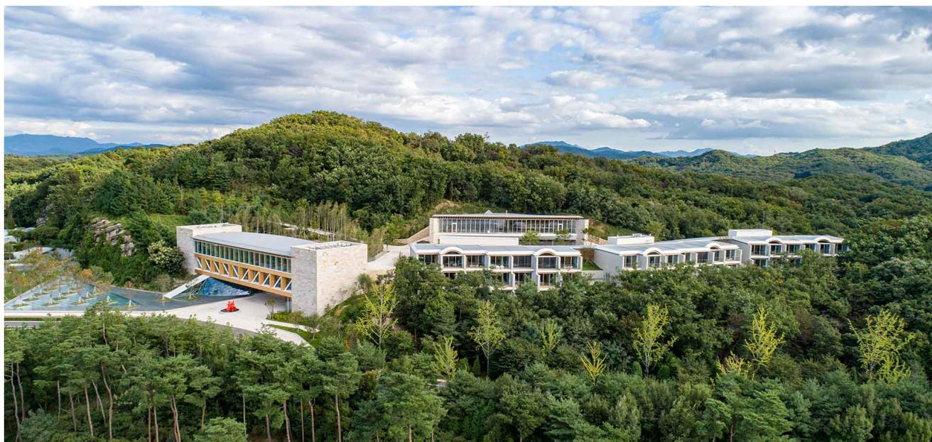
ハムレットは、2009年竣工のヘスリー・ナインブリッジズ・ゴルフクラブの隣に建つ宿泊 研修センターを兼ねた4つの建築群のプロジェクトである。クラブハウスと同じ自然の材料の木造や石壁を用いて統一感を与えながら、自然との調和を建物それぞれ違ったアプローチで図っている。コンドミニウムは、細長くうねった傾斜のある地形に合わせて階段状に各階のヴォリュームを重ねることで、自然の地形を残しながら、各室からの眺望を楽しめるようになっている。連続したコンクリート壁は、鉛直荷重を無駄なく支持するために上階に行くにしたがい壁厚を減らし、それによってできた厚みの段差にスラブを架けることで、接合部の合成を高めている。スラブは、連続した木梁、CLT板、コンクリートによるハイブリットとし、コンクリートで遮音性能を高めながらも、木梁とCLT板をコンクリートの型枠として機能させそのまま残すことで、コンクリートの養生期間を省き工期短縮に寄与し、何より木の暖かみのある空間を得ている。
