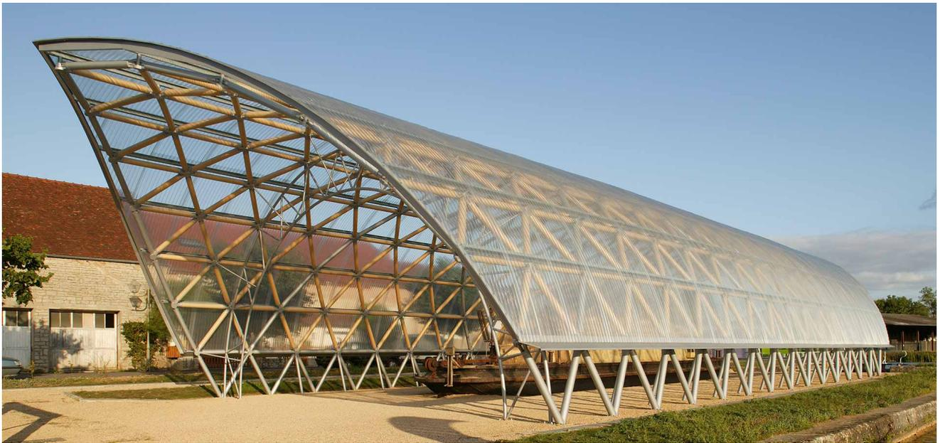
歴史的に重要な運河船を格納するためにつくられたポート・ハウス。紙管をつかった三角格子のグリッドシェルで構成され、外面をポリカーボネートで覆っている。「ハノーバー博覧会日本館」の架構で使用したものと同じ大きさの紙管を使い、同じ実験データでフランスの認定を受けられるよう、鋳型アルミニウム製のジョイントを開発した。
