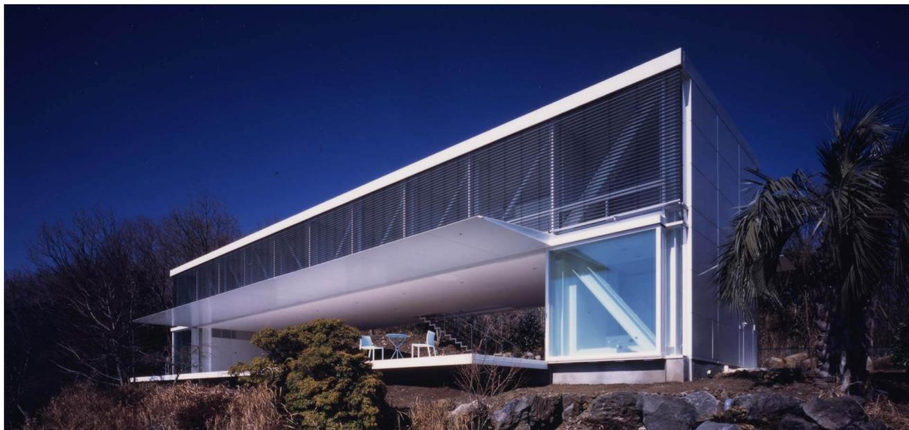
海から続く小高い丘のほぼ頂上に位置する敷地にはじめて立ったとき、建築自体をピクチャー・ウィンドウとみなし、水平に広がる景色を切り取り、さらには海からの景色の流れを建築が仕切ってしまうせずに、裏の雑木林に連続させていくことを考えた。そこで2階全体を梁せいとした20mスパンのトラスを構成し、1階を20m x 2.5mのピクチャーウィンドウとしている。
