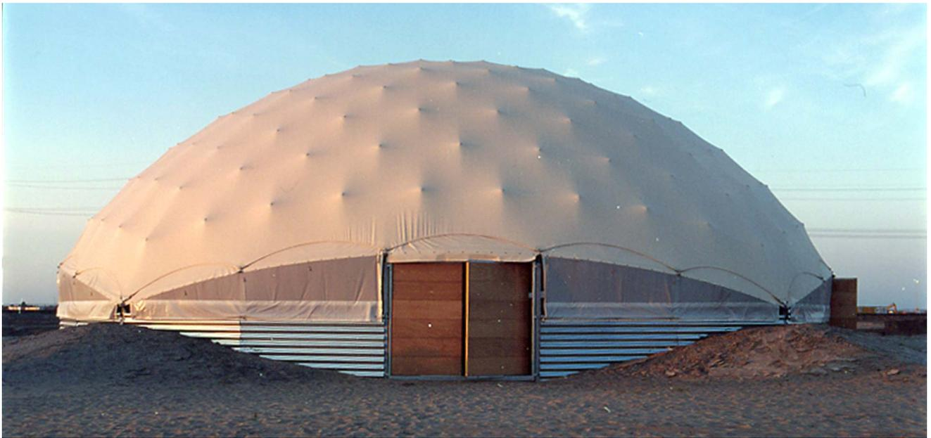
アムステルダムの劇団のための仮設劇場。安くて再利用可能な素材を使いたいという要望から紙管を使い、またアムステルダムでの公演後ユトレヒトに移設されるため、組み立てと解体が容易にできるように星型のジョイントで短い紙管をつないでいくグリッド構造によるドームとしている。
