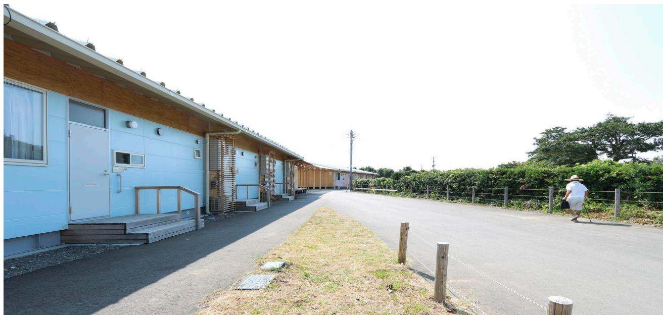
熊本地震は2016年4月14日と16日に震度7を観測した地震で、熊本県では大きな被害がありました。この集合住宅は地震の被災者向けの、熊本県御船町の10世帯、3棟の木造仮設住宅とコミュニティスペースです。仮設住宅の構造は木材と合板を組み合わせた構造パネルから成ります。パネルは工場で製作され、プレファブ化することにより現場での工期が短縮されます。構造パネルを組み立てた後は、屋根を掛け、構造パネルの間に壁やサッシ、建具を入れます。坂茂建築設計及びボランタリー・アーキテクツ・ネットワーク、慶應大学SFC坂茂研究室、熊本大学で協働しながら敷地を利用したコミュニティー・スペースの設計を行いました。
