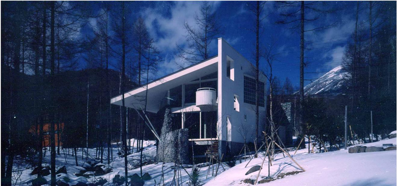
「3枚の壁」というコンセプトを敷地の状況を読み解きながら展開している。既存の炭焼き窯のイメージを残した石積みの壁を前面道路に沿って立て、さらにそれを敷地を横切る小川に沿ってカーブさせた。これにより内部を規定している。レッドシダーを縦張りにした2枚目の壁には階段や外部通路などのサーキュレーションを配置し、煉瓦のシリンダーである第3の壁にはサービススペースを集めている。
