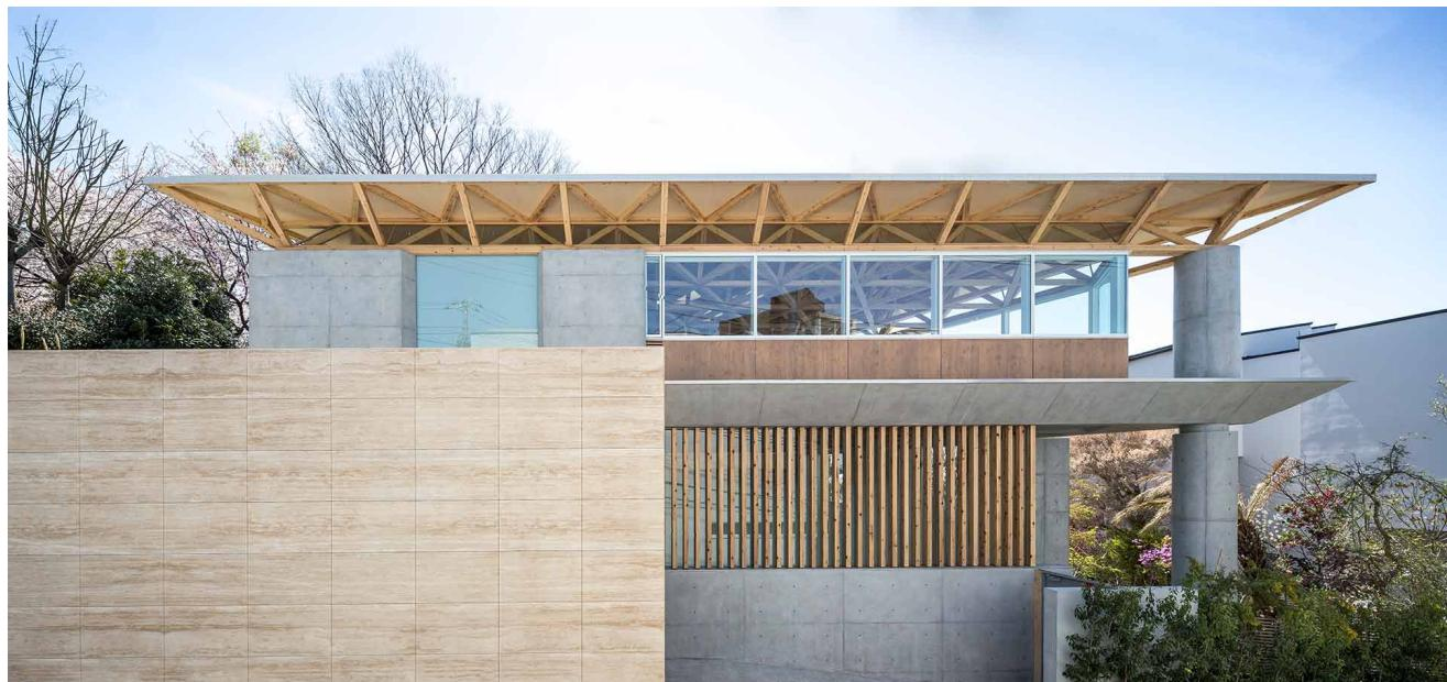
鋭角の傾斜地という複雑な敷地に、今後の分筆を加味し更に制約が付き、結果的に三角形の建設可能なエリアが与えられた。三角形という無駄なスペースを作らず柱や壁を配すのが困難な平面に対し、プランの自由度を確保するため、RC造のワッフルスラブと木造スペースフレームの屋根を用いた。ワッフルスラブは、変形しない三角錐の型枠とすることで通常の矩形より補強の費用を減らすことができ、そして何よりも美しいパターンの天井ができる。屋根の木造スペースフレームは、RCワッフルスラブと同じジオメトリーとし、コンクリートと木という異なる素材を使いつつも、建築全体のハーモニーを作り出している。
