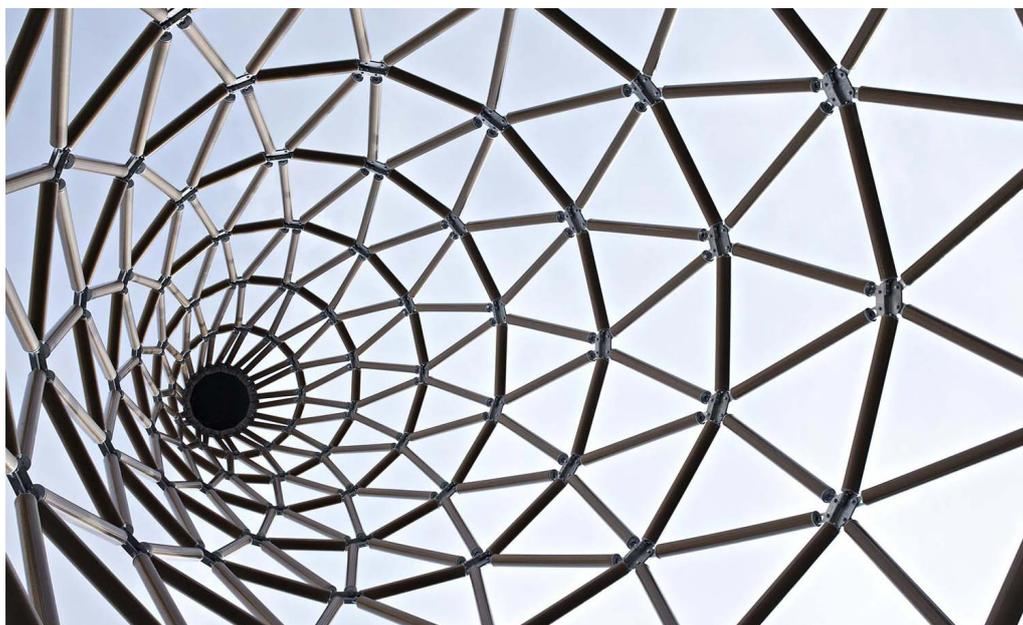
ロンドンデザインフェスティバル主催の企画として制作されたタワー。普段見慣れた素材を使って通常概念を覆すという企画コンセプトから、紙管を使ったモニュメントを製作。星型のジョイントで紙管をつないでいくグリッド構造を用い、紙管構造のタワーとしては世界一の高さ22mとなった。この構造は、展望台や温室、家などさまざまなものへと応用ができる。
