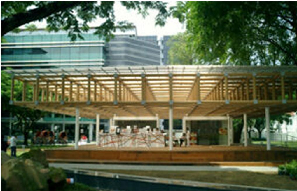
シンガポール・ビエンナーレ2006のための案内所、兼プレスセンターである。紙管による初めてのスペース・フレーム構造。ビエンナーレ終了後移設を想定して紙管、金属接合部、柱管、基礎の全てのディテールを決定した。
