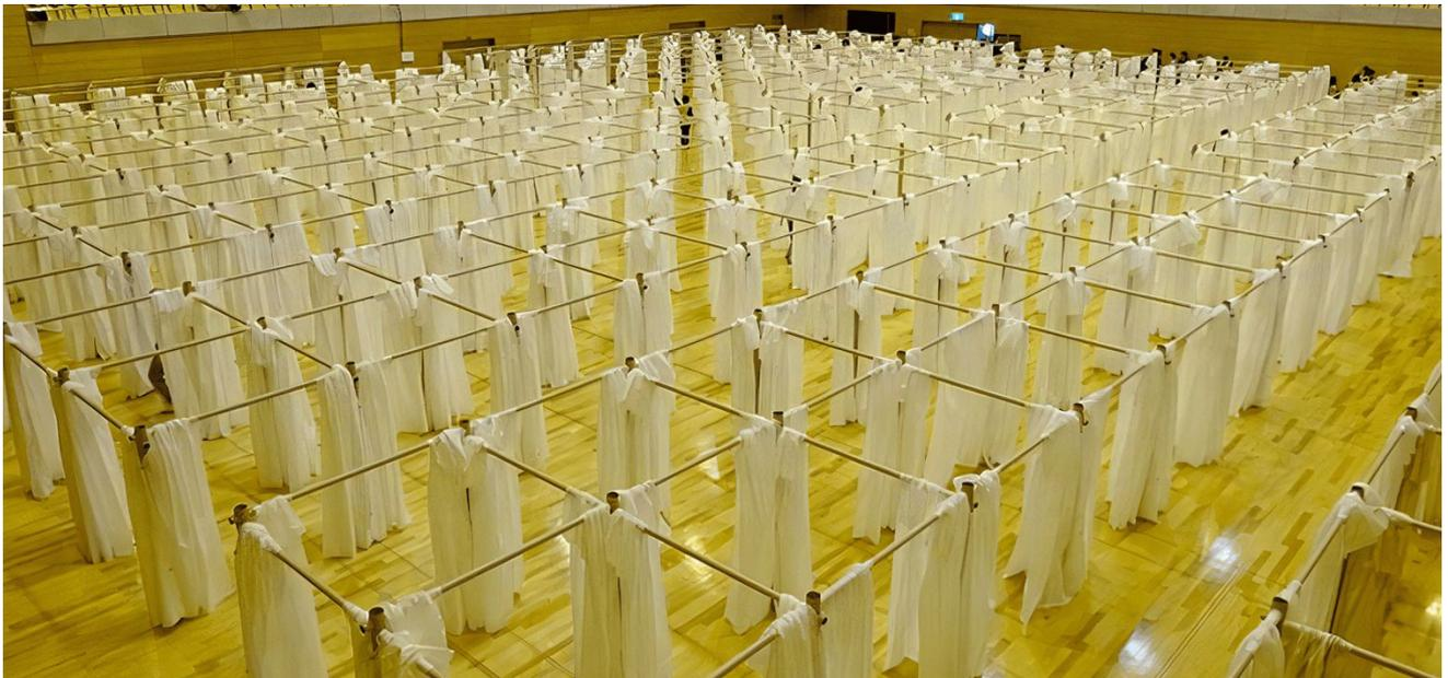
熊本地震は2016年4月14日と16日に震度7を観測した地震で、熊本県と大分県で大きな被害がありました。ボランティア・アーキテツ・ネットワーク + 慶応大学SFC坂茂研究室 + 熊本大学田中智之研究室では、4/23 ~ 6/23にかけて、避難所に紙管と布を用いた簡易間仕切りシステムの設営を行いました。
