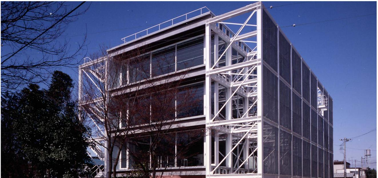
予算、工期、そして重量機械を多層に設置する条件より、この工場では鉄骨造とプレストレスPC板を併用する構造システムを採用している。東側と西側に基礎にも地上にもつなぎ梁がない4層の鉄骨フレームを建て、全体の水平力をこのフレームにおいて負担し、その上にDTスラブをピン状に置いている。つなぎ梁がないためにフレーム間をクレーンが出入りできるのでDTスラブの設置は楽になり、またブレースなどに邪魔されずに機械の配置換えができるフレキシビリティの高い作業空間ができた。
