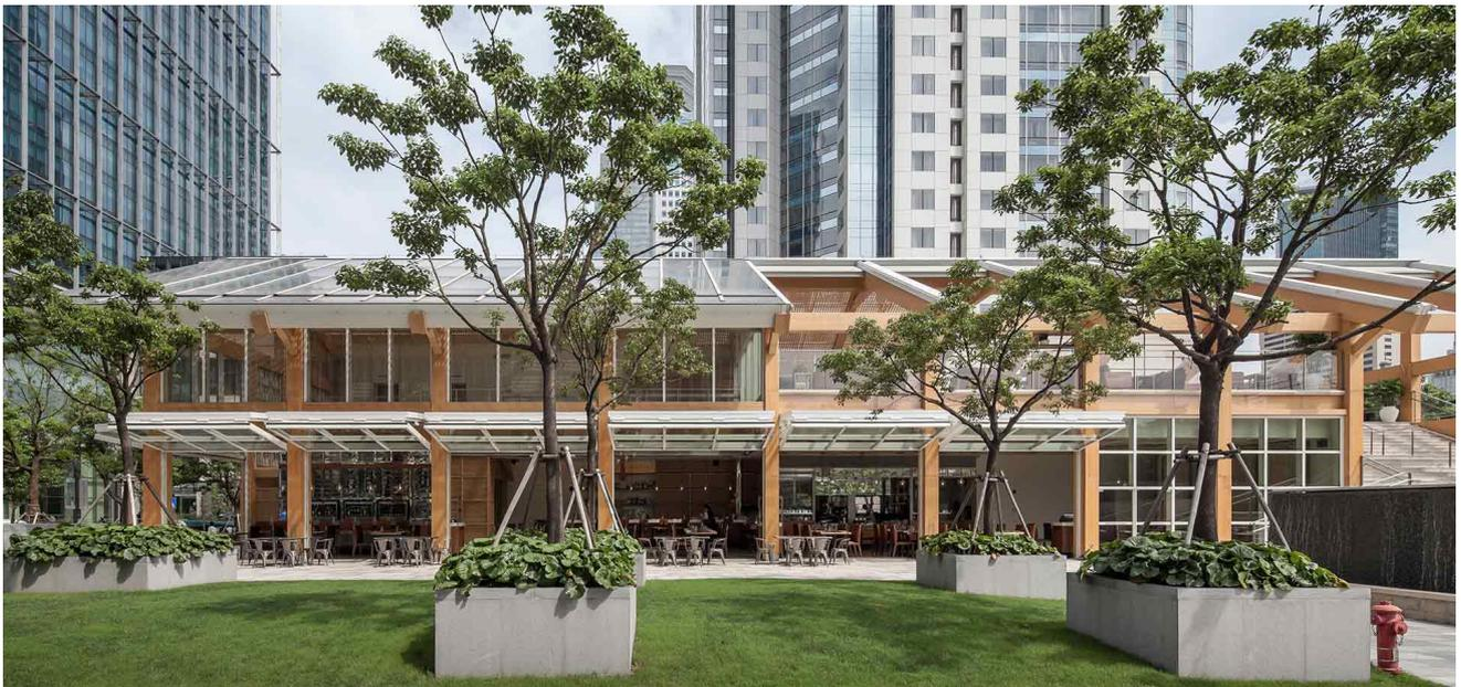
上海の新しいメガ都市開発に適したレストランとラウンジを設計案。近くの「毛沢東旧居」の伝統的な長屋風のスタイルを保つため、積層竹の構造体と角度のある屋根とを組み合わせた。レストランは2階建てで、1階にはメインダイニングとワインバー、大階段をのぼると、屋上テラスへとつながっているラウンジバーがある。北側のガラスのファサードは、紙管と半透明の防水紙にLEDストリップを織り交ぜた。ファサード全体は電動のガラス窓となっており、開け閉めが自由である。ガラスの屋根の間には竹の網戸があり、竹の網戸を閉めるとやさしい自然光が室内に入っている。
