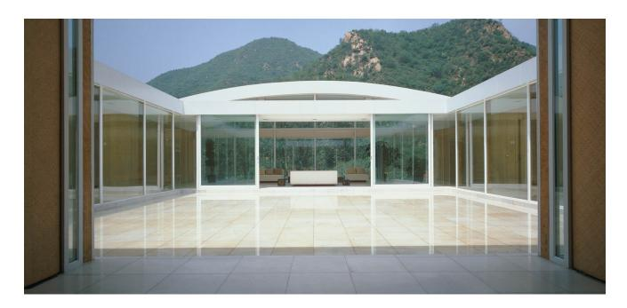
万里の長城を見渡せる山腹に建つ「家具の家」。中国においては伝統的な、中庭を囲んだ平屋構成とし、遠い現場でも監理が比較的楽なプレファブ住宅システムの「家具の家」としている。竹の集成材を開発し、家具を竹の集成材のフレームと梁で構成し、仕上げ材として、内部側には中国で伝統的に用いられる竹を編んだ既製品のマットを、外部では竹のフローリング材を使用した。
