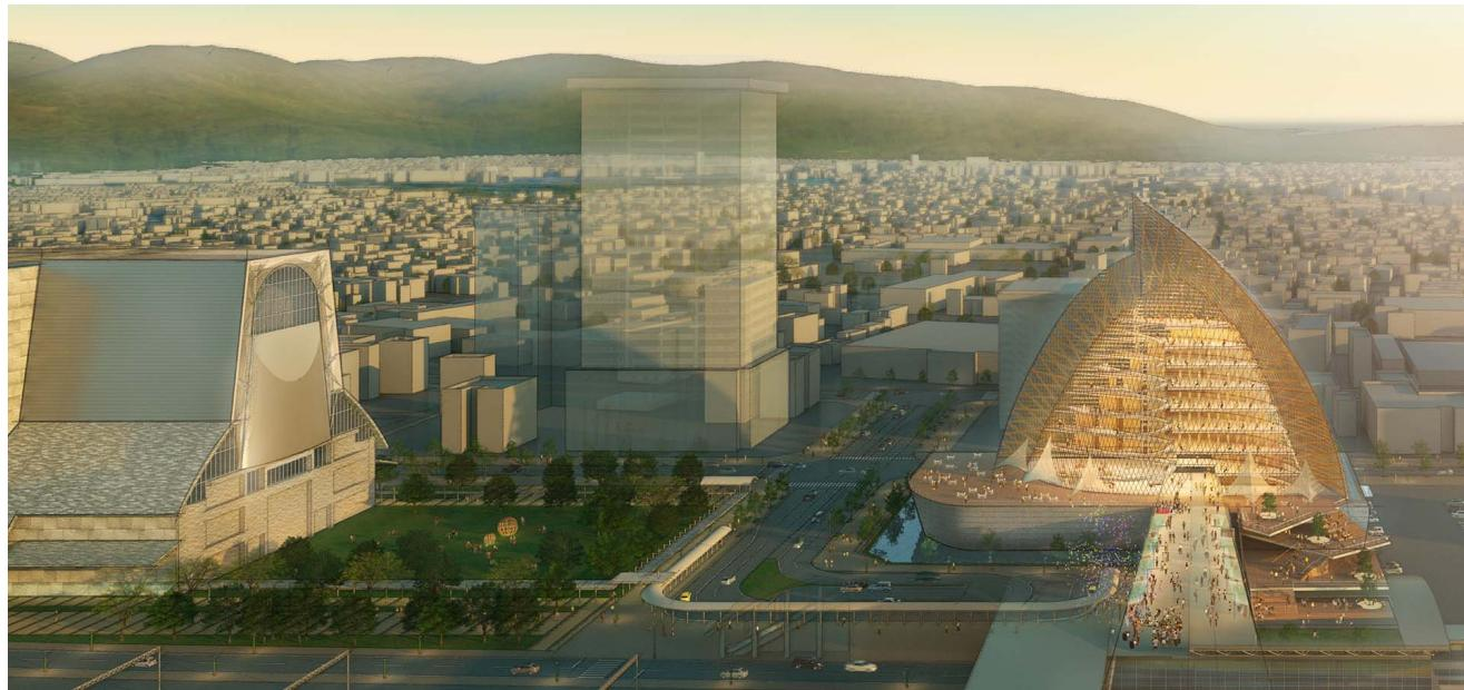
東静岡駅前の東西軸、南北軸を形成するために、隣接する磯崎新氏設計のグランシップに呼応する高層の図書館を計画した。駅から伸びるペデストリアンデッキは図書館を貫通し、南側の遊歩道（ブルーバール）とつながっている。書庫は階高を抑え、積層することでフロアごとに本を分類でき、目的の書庫へアクセスしやすく、管理もしやすくなる。各階をエレベーターと階段だけでなく、緩やかな斜路で有機的につなげ、その途中の広い踊り場を閲覧スペースとしていることで、エレベーターに頼らない楽しい移動や居心地の良い多様な学びの場をつくりだした。北面のファサードは駿河竹千筋細工のように繊細なカーテンウォールとし、南面は美しい青緑色太陽光パネルで被うことにより、環境に配慮しつつシンボリックな形態とした。
