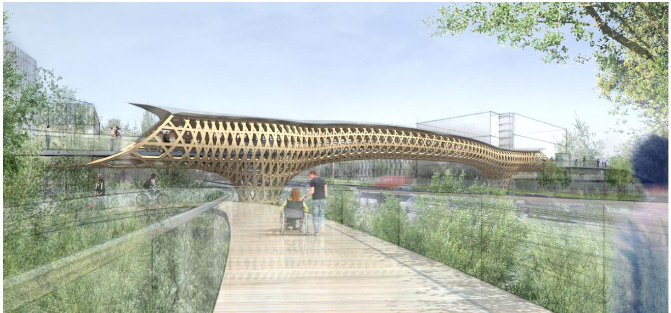
パリ市を囲う環状高速道路の上に架かる歩道橋のプロジェクトである。現在パリ市北部では再開発が行われており、この歩道橋は再開発地区とその北に位置するオーベルヴィリエ市を結ぶ、市民の新たな交通経路として計画されている。本プロジェクトでは唯一の再生可能な構造材料である「木」を使い、高速道路に架かる世界初の木造歩道橋となっている。耐久性に優れたAccoya（アコヤ）を使用することで、高速道路の上という厳しい環境条件下であっても木材のみの構造が可能になっている。アコヤとはアセチル化することで耐久性を飛躍的に高めた、世界最先端の無垢木材である。樹木で覆われた木のデッキの斜路を通り抜けると高速道路に架かる「木のトンネル」に至るというシークエンスが意図されており、喧騒の中にあって木に包まれた安心感のある、緩やかな交通の流れを市民が享受出来るようになっている。
