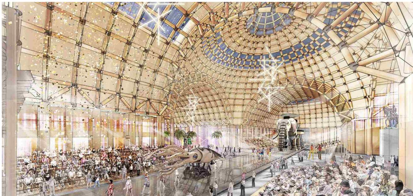
パリの中心、シャンゼリゼに位置するグラン・パレは1900年に建設された歴史ある展示会場および美術館を含む複合施設であり、改装工事で閉館する期間中の代替の仮設展示空間をエッフェル塔前の広場に建設するためのコンペが行われた。我々の提案は、紙管構造によりオリジナルのグラン・パレのプロポーショナルを忠実に再現することであった。非常に高い遮音性能が要求されていたため、屋根およびファサードの構成には特に注意が払われた。すべての部材をモジュール化することにより、様々な異なる構成で組み立て直すことが可能である。
